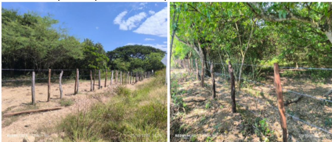
Figura 5. Cercos instalados en los predios El Laurel y El Rosal respectivamente.
